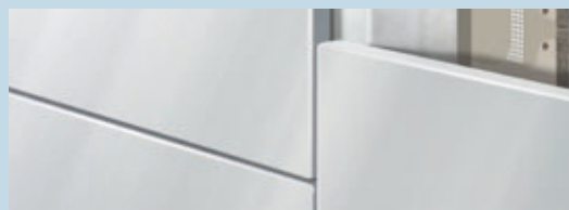
Облицовка композитным материалом
